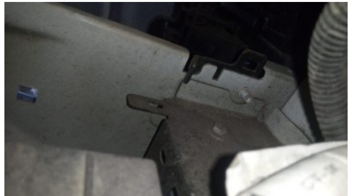
Estrutura Longarina Esquerda
