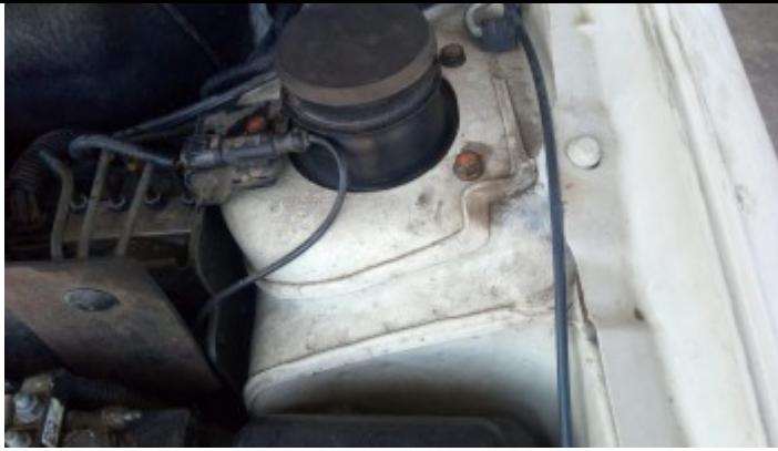
Estrutura Torre do Amortecedor Esquerdo
