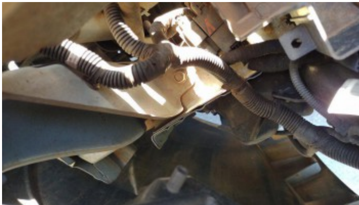
Estrutura Longarina Esquerda
