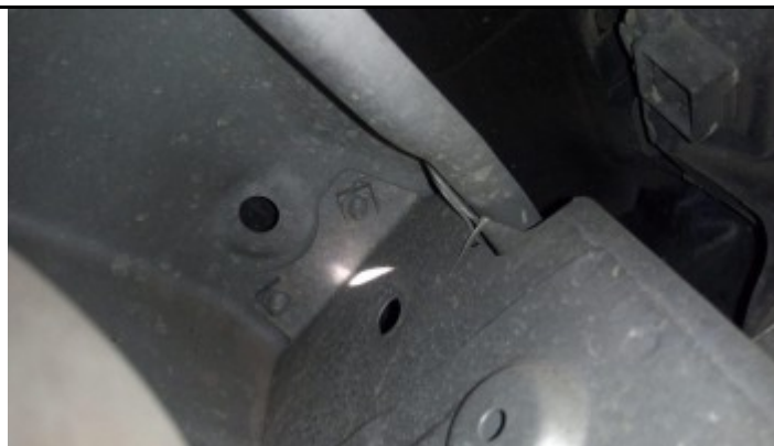
Estrutura Longarina Esquerda
