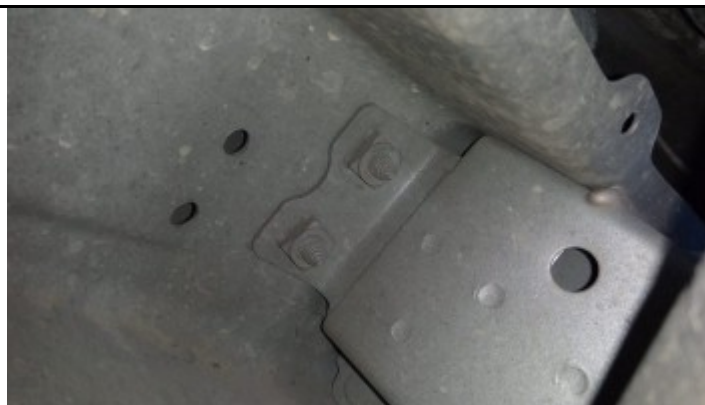
Estrutura Longarina Direita
